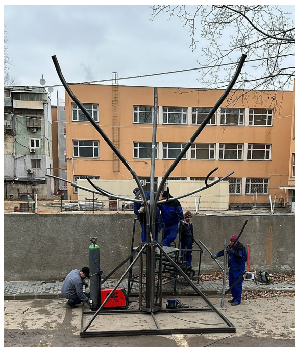
Figura 30. Subansamblu ramura principala
