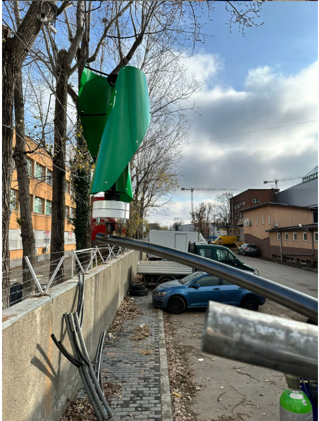
Figura 34. Fixarea turbinelor eoliene pe ramuri
