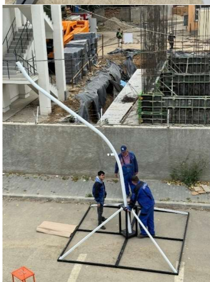
Figura 2. Instalarea ramurilor principale pe placa suport
