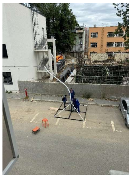
Figura 2. Instalarea ramurilor principale pe placa suport
