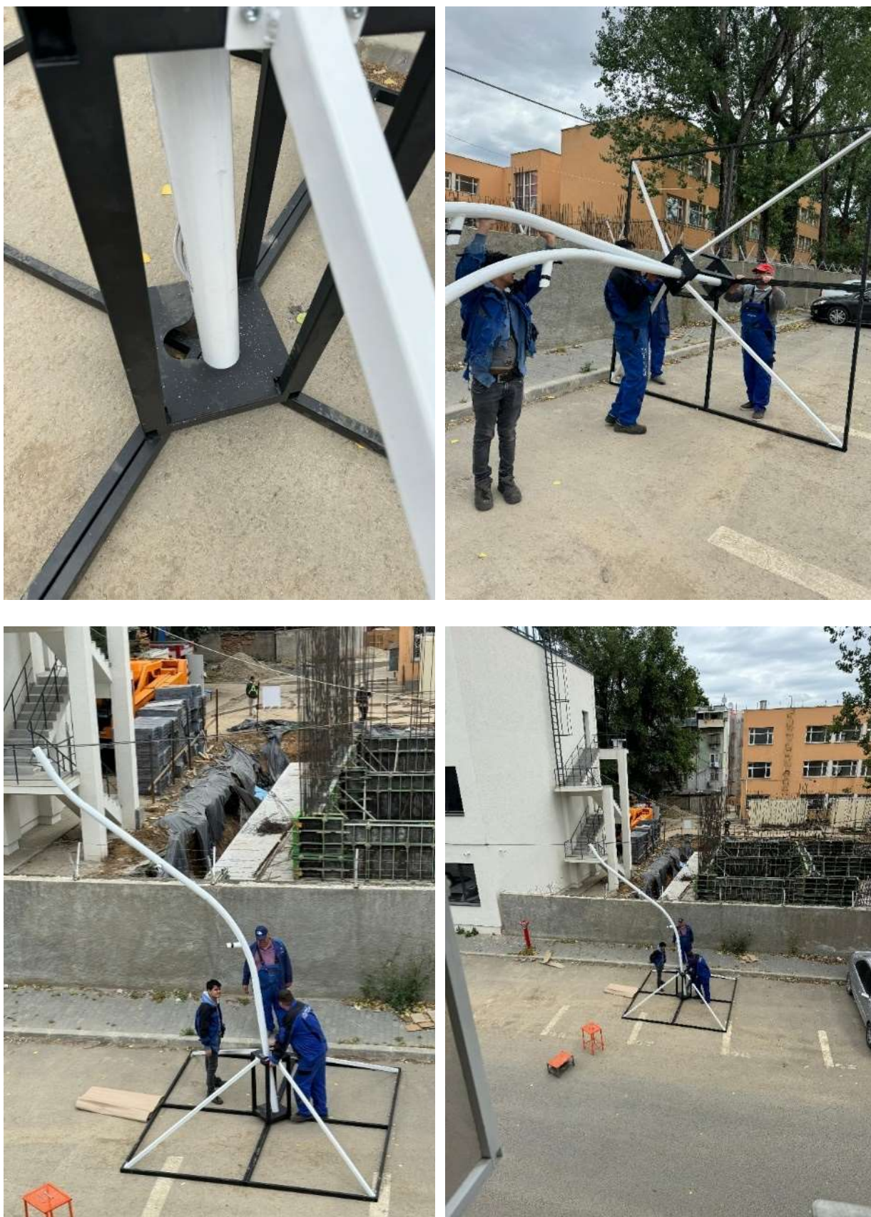
Fig. 5. Instalarea ramurilor principale pe placa suport
