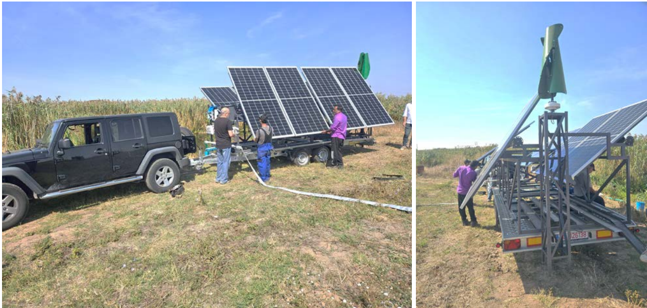
Fig. 13. Aspect din timpul orientării panourilor fotovoltaice și amplasării turbinei eoliene
